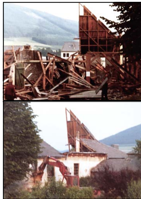
Abriss der Schützenhalle im Jahr 1967
